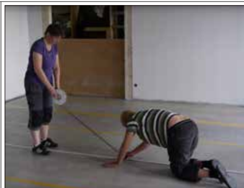
Pose du câble plat sur le scotch double face
