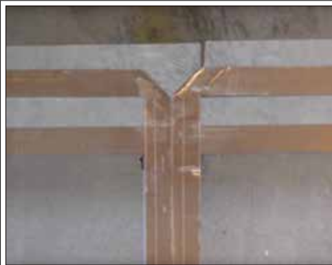
Détail pliure du câble dans les angles
