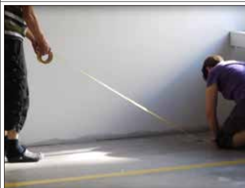
Pose de scotch double face suivant un tracé préalablement réalisé
