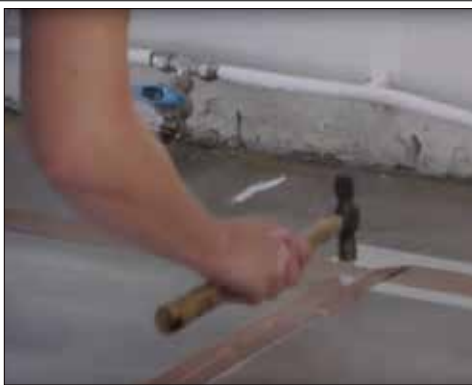
Aplanissement du câble dans les angles avec de légers coups de marteau
